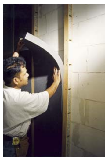
Vstavljanje akustičnega polnila
